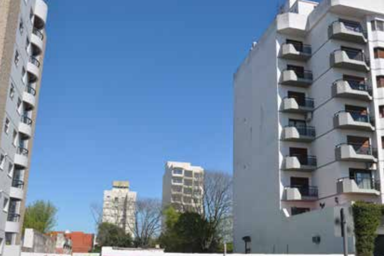
Solar donde se fundaría el edificio Urbano Plaza, ubicado entre dos construcciones de la Empresa, Torre del Sol (2001) y Edificio Plaza (1996).
