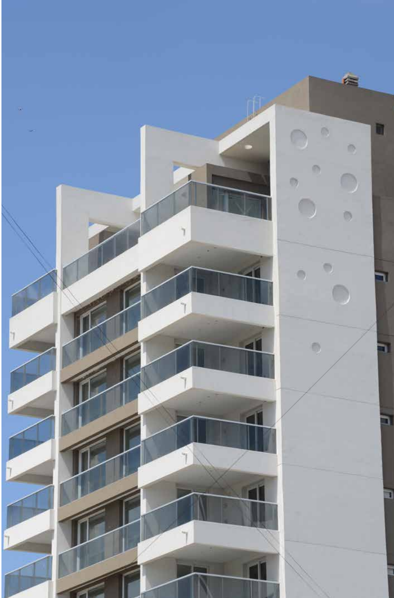
Se puede observar, dentro del diseño formal, el único gesto de su volumetría. Dos patas verticales que recorren todo el frente, sostienen en el remate, a una viga cinta horizontal que baja por ambas medianeras hasta PB.
