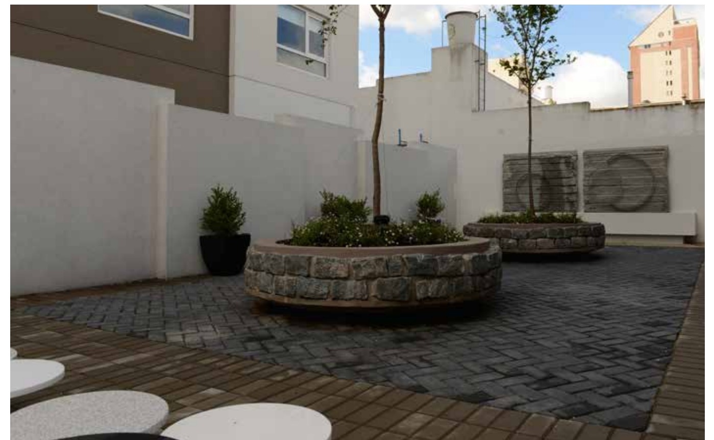
Dos grandes macetones circulares de adoquines de granito, una fuente de agua sobre piedra en la medianera ornamentada con círculos de acero inoxidable y un ramillete de pequeñas mesitas de granito de 3 colores visten el Patio del Espacio Gourmet.
