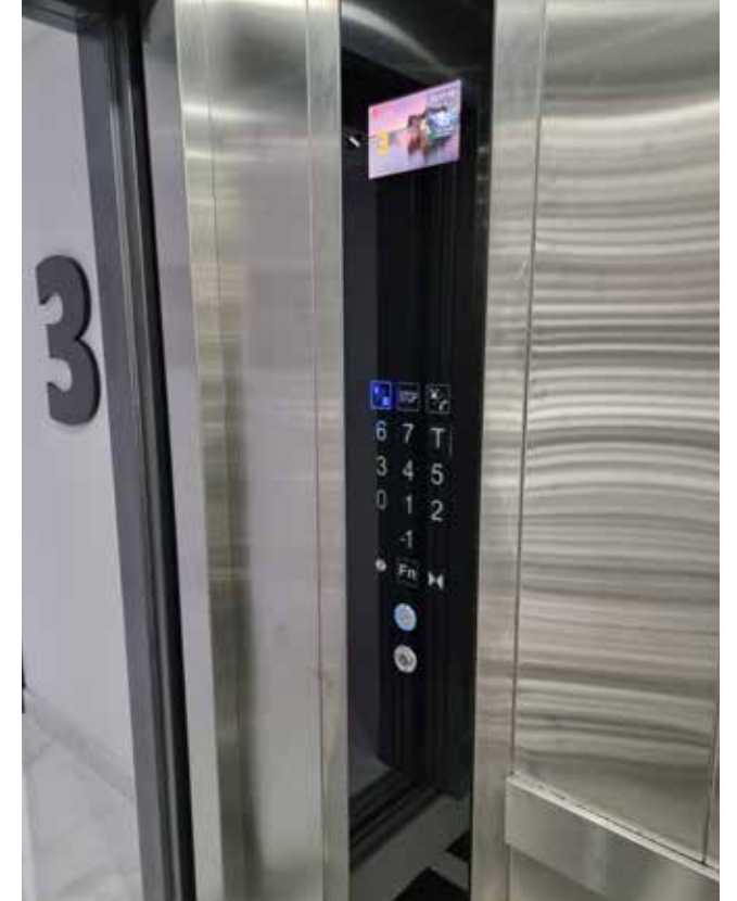
Innovación para cabinas de ascensor con botonera touch screen. Botonera táctil en cabina y palier e indicador de posición y dirección con pantalla led, sobre un frente integral de vidrio negro.
