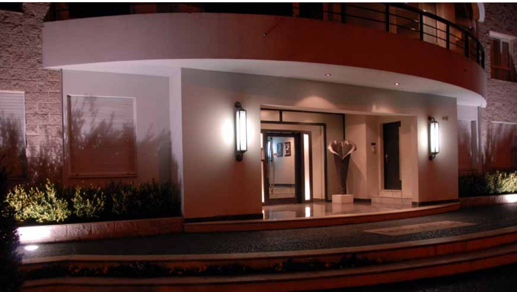
Fachada iluminada del frente de Torres del Sol. La iluminación exterior entra a formar parte del proyecto e interactúa con la expresión del diseño.
