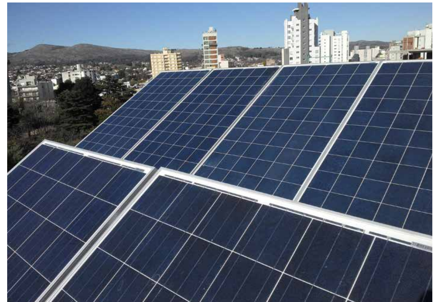
Experimento disruptivo realizado en el techo del Espacio Gourmet del edificio, que permitió "inyectar" energía solar fotovoltaica a la red pública, a cuenta del consumo de partes comunes del edificio. Hito en la producción de energía eléctrica de forma privada en la Argentina.
