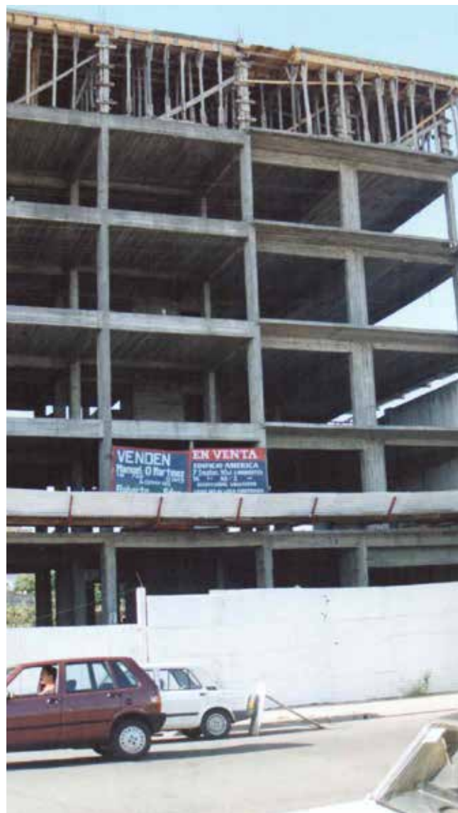
Imagen del encofrado de la 6ª losa. Momento del inicio de obra del Edificio América y génesis de Bértoli Desarrollos Inmobiliarios, principios de 1992.
