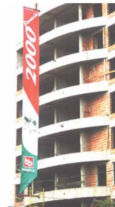
Intervención de la empresa sobre la fachada de la Torre del Sol en construcción deseándole a los tandilenses una feliz entrada en el siglo XXI
