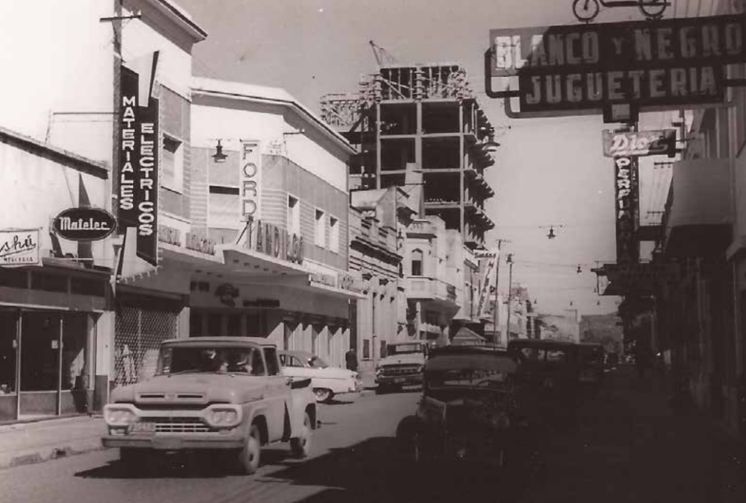
Al fondo, en la esquina de Sarmiento y Rodríguez, se observa la construcción del edificio que durante muchos años cargó la leyenda (o el dato verdadero) de estar inclinado o "fuera de plomo", dicho en la jerga de la arquitectura.
