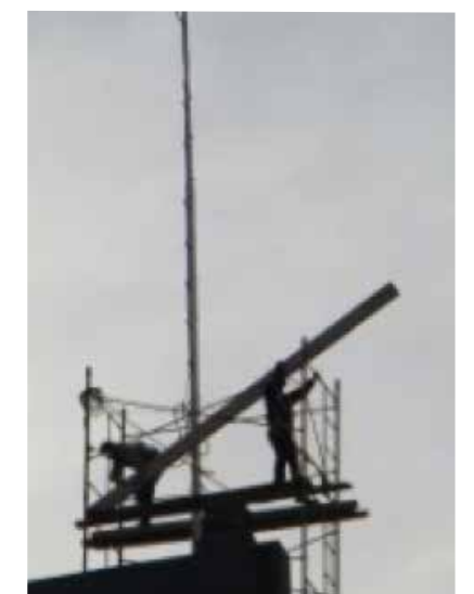
Momento de la colocación del mástil
