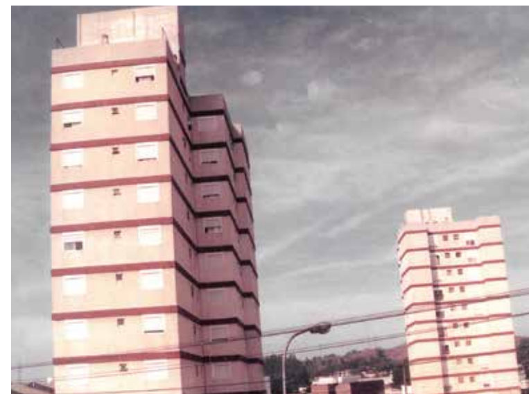
La Torre Boreal, Rodríguez 1550, La Torre Austral, Yrigoyen 1551.
