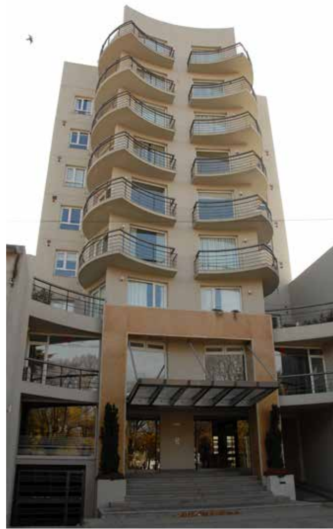
Obra terminada donde se observa el protagonismo del panel cóncavo y las curvas de los balcones.
