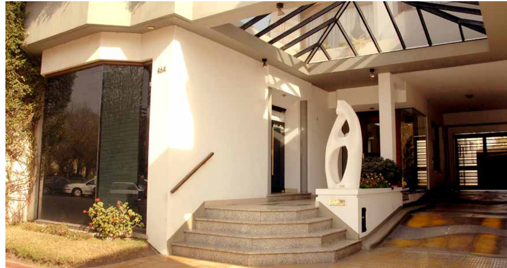
Primer oficina 85 m² habitables en 2 plantas, en la Planta baja del Edificio Plaza, Chacabuco 464.
