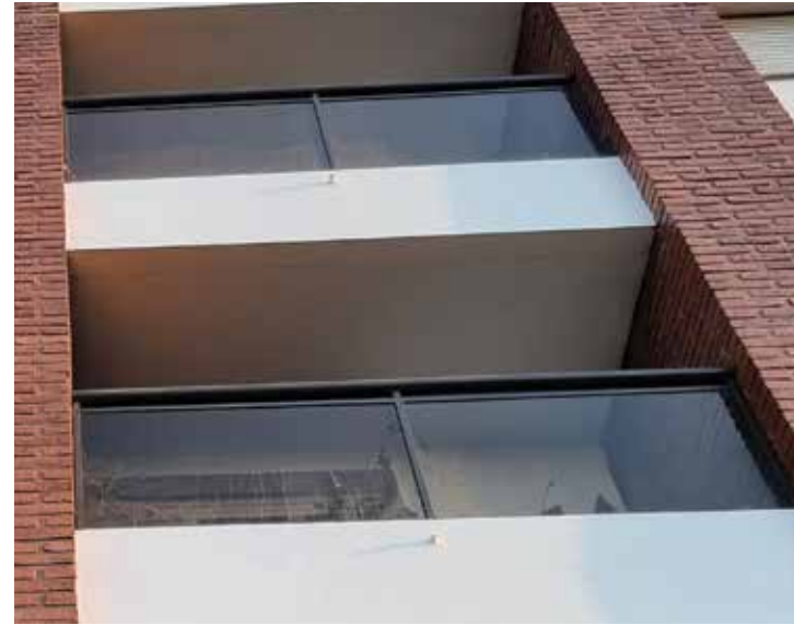
Barandas de balcones con cerramientos de vidrios laminados tonalizados.
