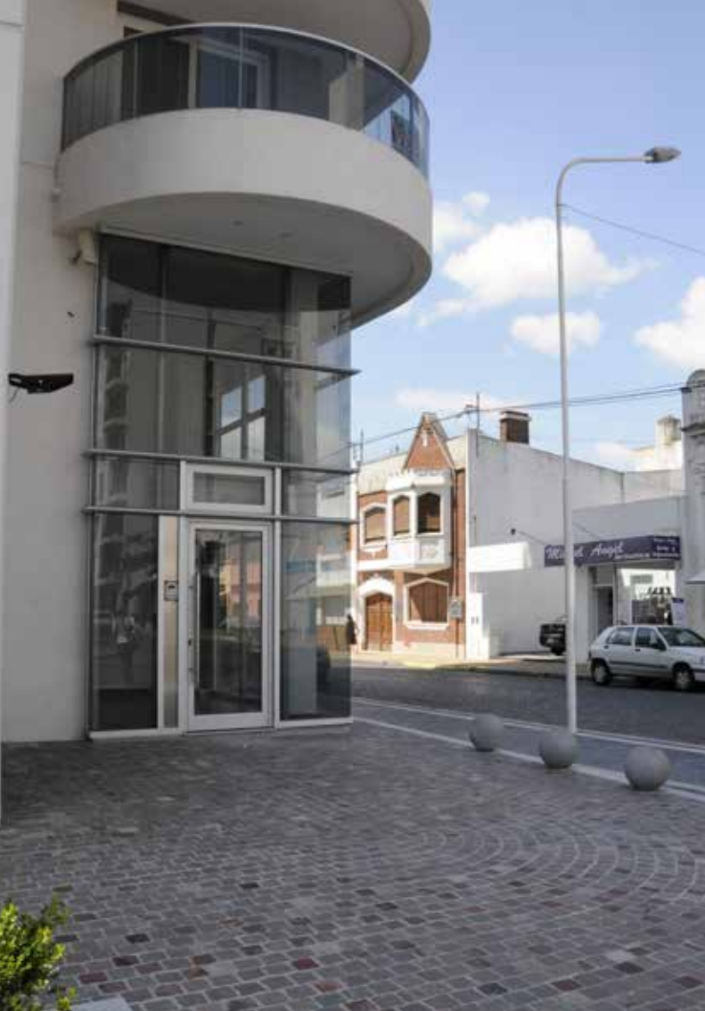
Esquina. Vista de la integración amigable del terreno del edificio al peatón, ampliando la vereda pública con pisos de pórfido patagónico y con el detalle de 3 esferas de piedra marcando la línea municipal.
