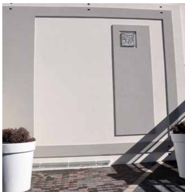
Paredes medianeras con diseño de líneas y cuadros en sobre relieve en dos colores.
