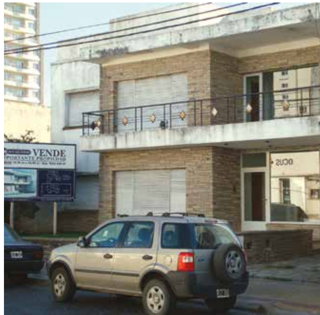
Elegante propiedad donde se construirá Alem Suites que formó parte de la innovación de la arquitectura de la época (año 1959).
