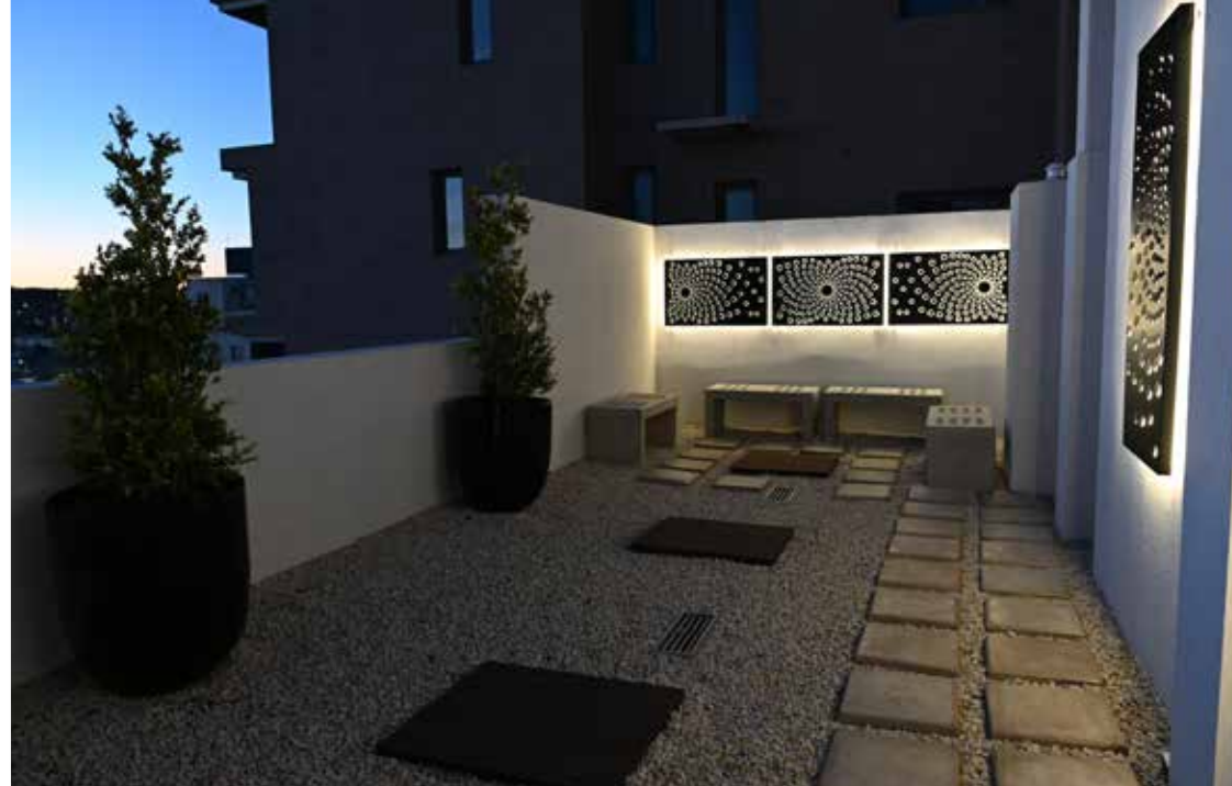
Iluminación con paneles decorativos de chapa laqueada negra, utilizando el corte con la técnica láser, ubicados sobre sectores de la Terraza Social (contra frente) y los balcones terraza del Espacio Gourmet.
