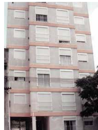
El Edificio Tronador, Rodríguez 50.
